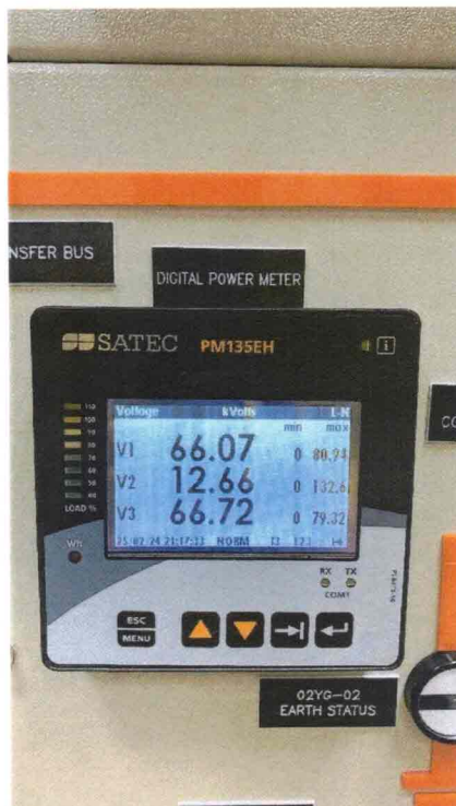
รูปที่ 2 แรงดัน 115 kV เฟส B ที่ สถานีไฟฟ้านครปฐม 2 เหลือ 12.66 kV
